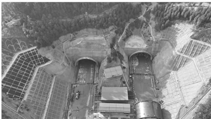
惠增高速项目观洞隧道
