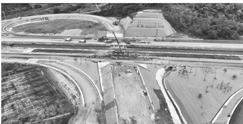
长深扩建项目石坝互通改建施工
