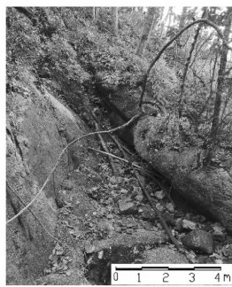
图 10 隧道出口段竖井上游山坡发育张性断裂照片
