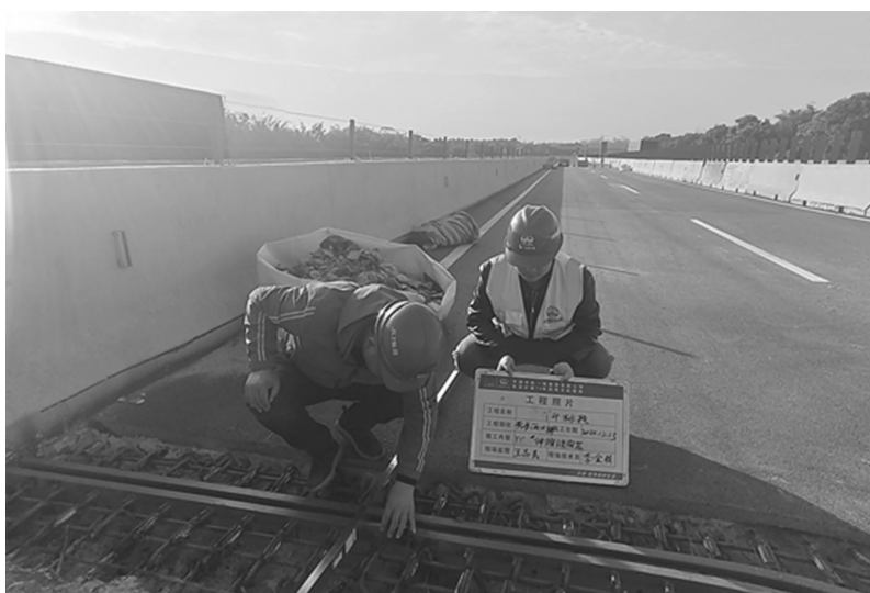
长深扩建项目黄果沥大桥伸缩缝安装工序验收
