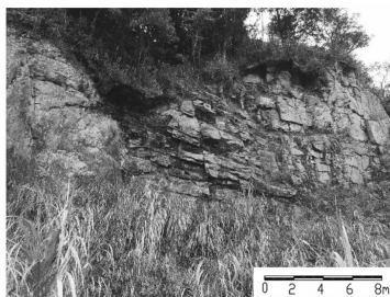
图 11 隧道进口段山坡发育张性断裂照片
