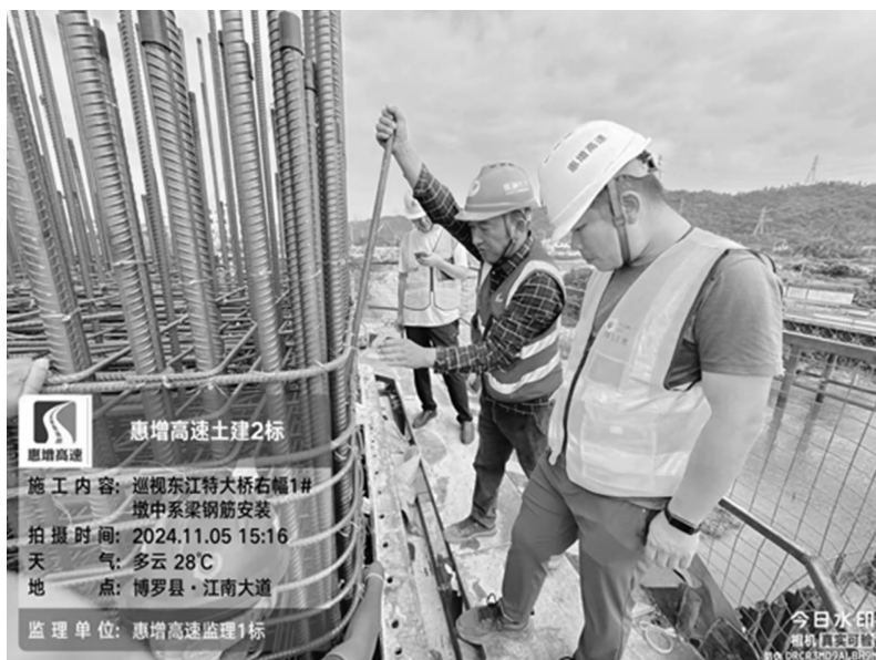
惠增高速项目总监办日常巡查
