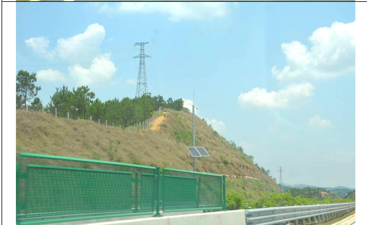
道路绿化（2018年现场照片）
