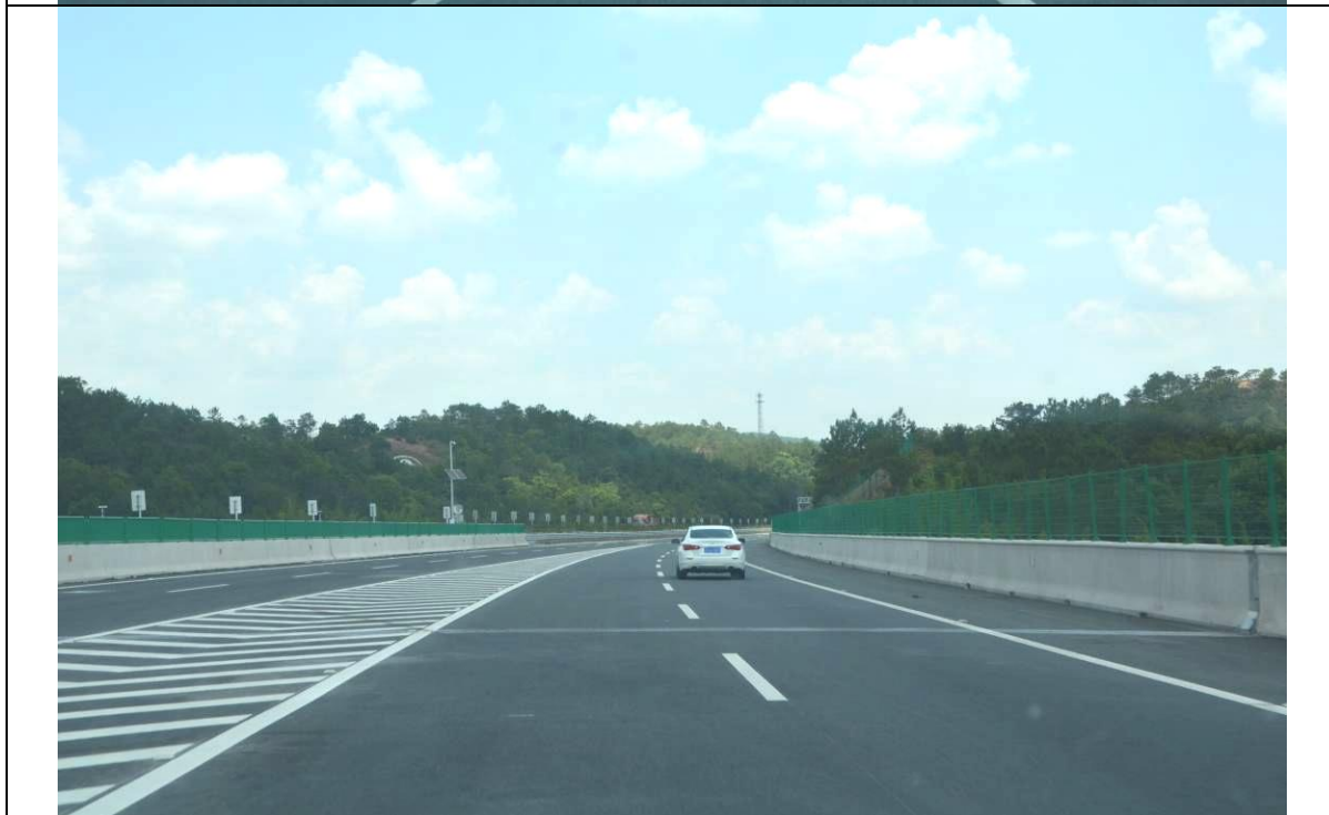
道路绿化（2018年现场照片）
