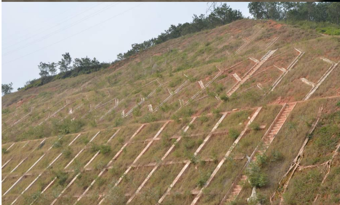
路基工程区 K49+800 (2016 年 12 月)
