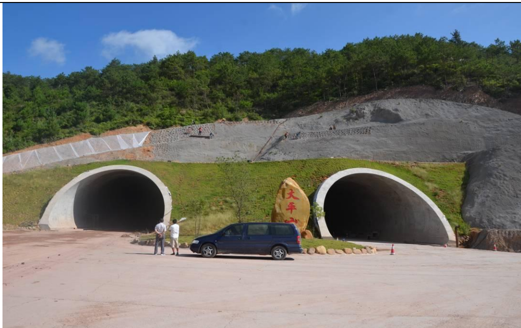
隧道工程区（2016年12月航拍图）
