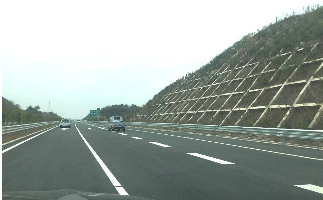
路基工程区（2017年现场监测照片）
