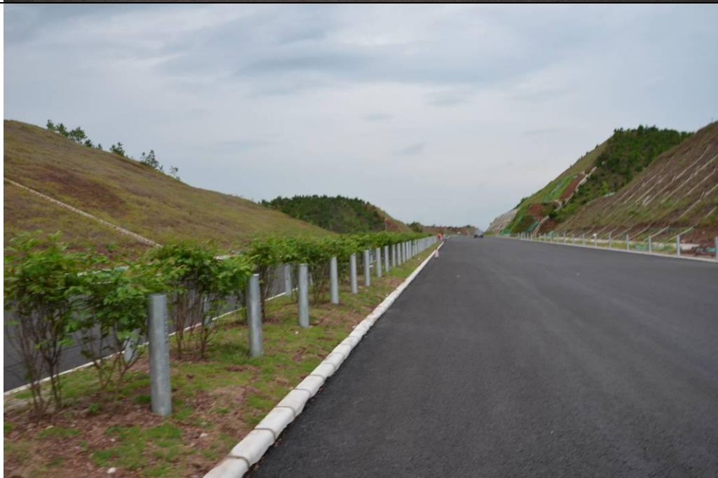
路基工程区（2017年现场监测照片）
