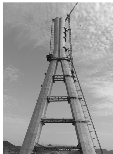
图 8 香山大桥施工现场
