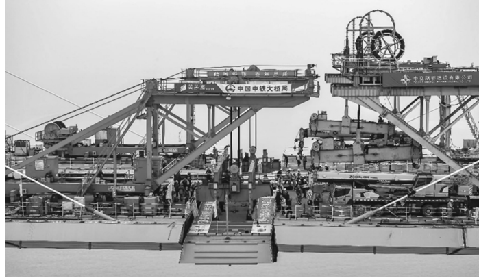
高栏港大桥合龙梁段吊装
