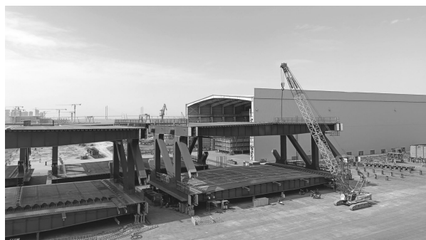
图 6 中铁山桥钢梁场
