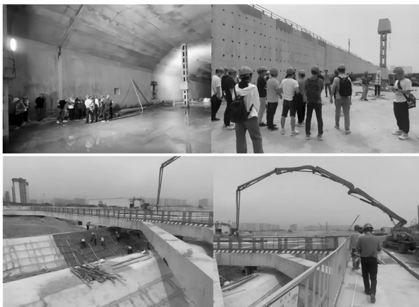
图2 北围隧道现场观摩
