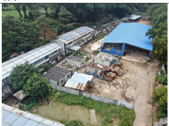
位置：南侧施工营区 现场：场地保留硬化交还权属单位
