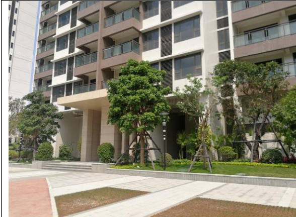
位置: 3#楼 现场: 可绿化区完成园林绿化工程, 植被恢复较好, 道路广场区已完成硬化
