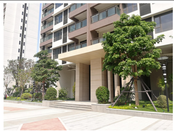
位置: 2#楼 现场: 可绿化区完成园林绿化工程, 植被恢复较好, 道路广场区已完成硬化
