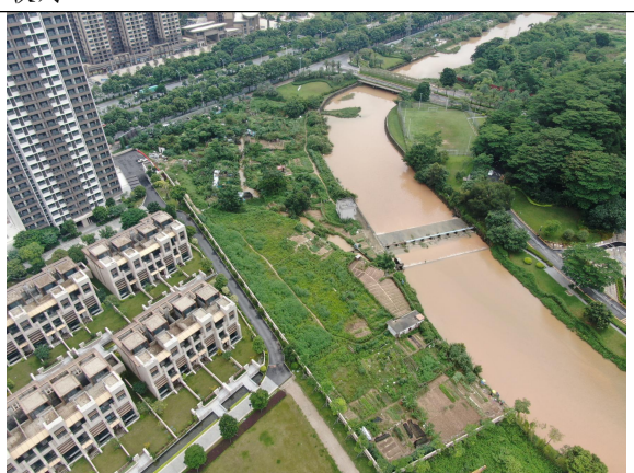
位置：东侧施工营区 现场：场地完成平整，采用混播植草方式进行防护
