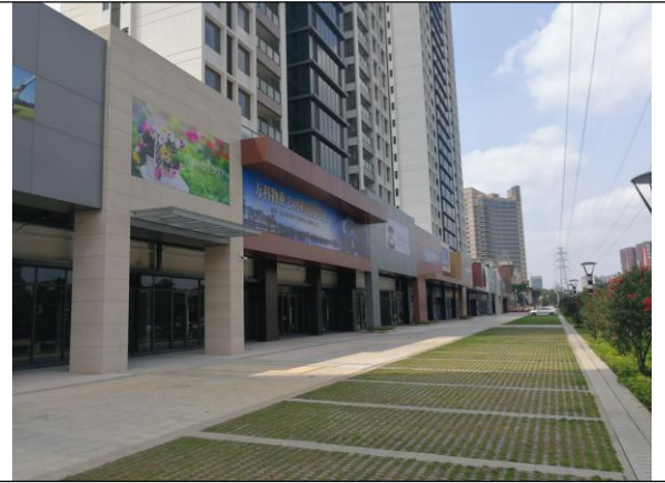
位置：主体工程区可绿化区 现场：可绿化区完成园林绿化工程，实施植草砖停车区
