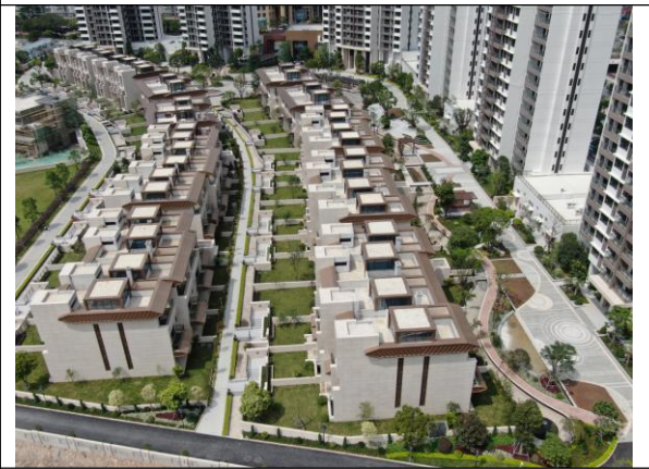
位置：低层建筑区 现场：可绿化区完成园林绿化工程，植被恢复较好，道路广场区已完成硬化
