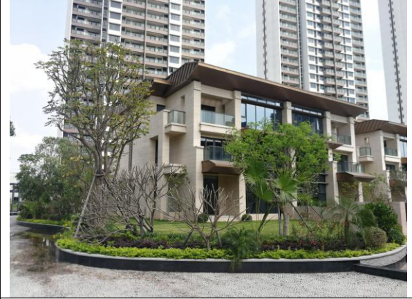
位置：11#楼 现场：可绿化区完成园林绿化工程，植被恢复较好，道路广场区已完成硬化
