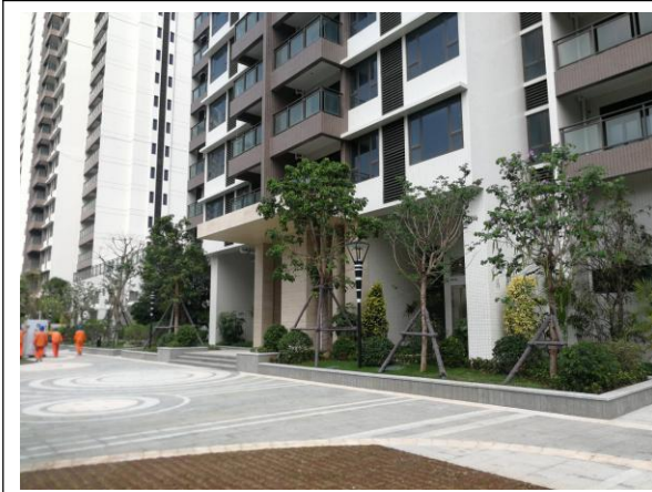
位置: 1#楼 现场: 可绿化区完成园林绿化工程, 植被恢复较好, 道路广场区已完成硬化
