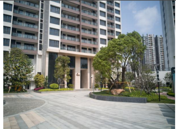
位置: 4#楼 现场: 可绿化区完成园林绿化工程, 植被恢复较好, 道路广场区已完成硬化
