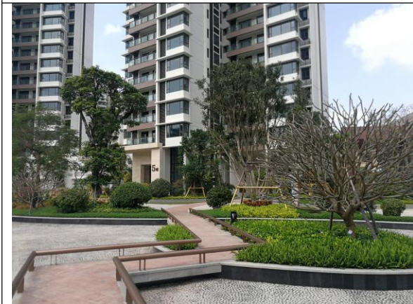
位置: 5#楼 现场: 可绿化区完成园林绿化工程, 植被恢复较好, 道路广场区已完成硬化
