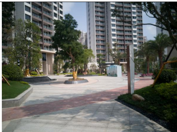
位置：主体工程区可绿化区 现场：可绿化区完成园林绿化工程，植被恢复较好，道路广场区已完成硬化
