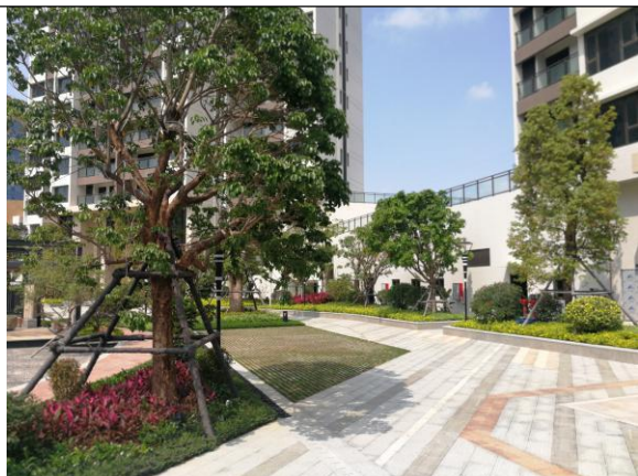
位置：主体工程区可绿化区 现场：可绿化区完成园林绿化工程，植被恢复较好，道路广场区已完成硬化
