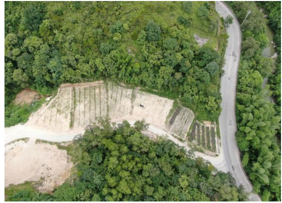
K76+300 右侧弃渣场
