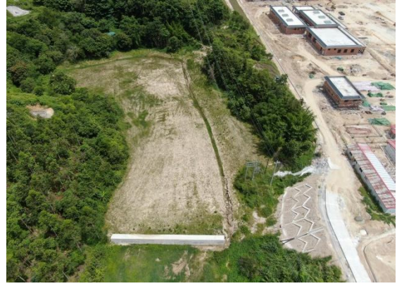
K70+100 右侧弃渣场
