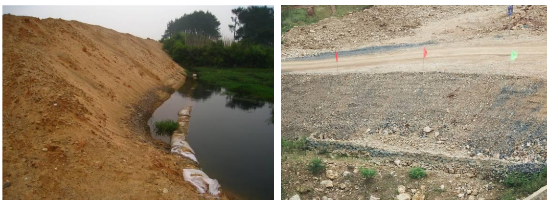
图 4-4 施工过程中临时拦挡
