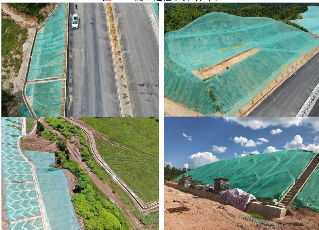
图 4-5 施工过程中临时覆盖
