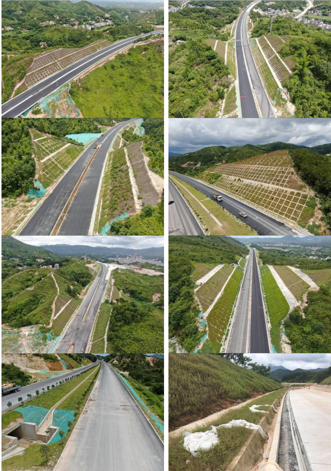
图 4-2 主线边坡框格骨架护坡及排水
