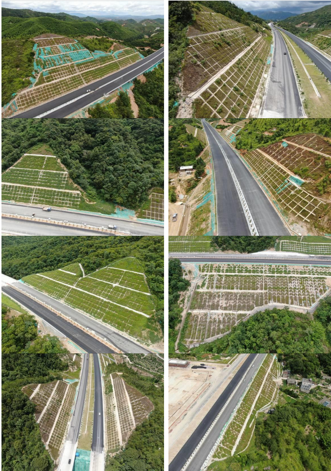
图 4-1 主线边坡框格骨架护坡及排水
