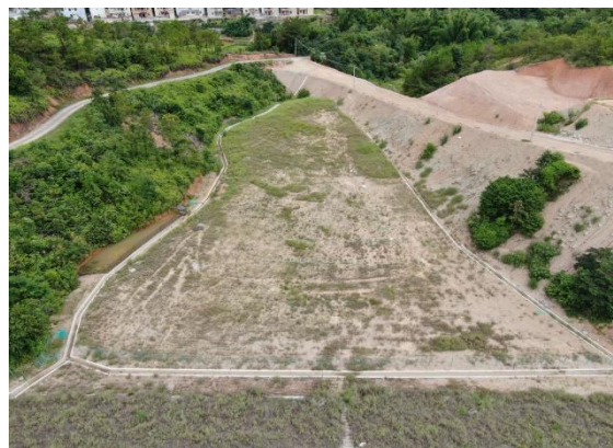
K50+500 右侧弃渣场
