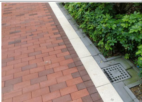
位置：景观绿化区 现场：可绿化区完成园林绿化工程，植被恢复较好，道路广场区已完成硬化
