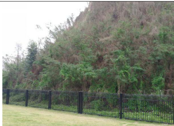
位置：边坡区 现场：边坡植被恢复较好
