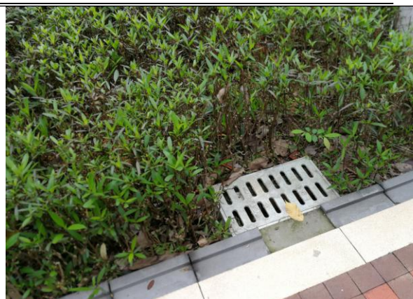
位置：景观绿化区 现场：可绿化区完成园林绿化工程，植被恢复较好，道路广场区已完成硬化
