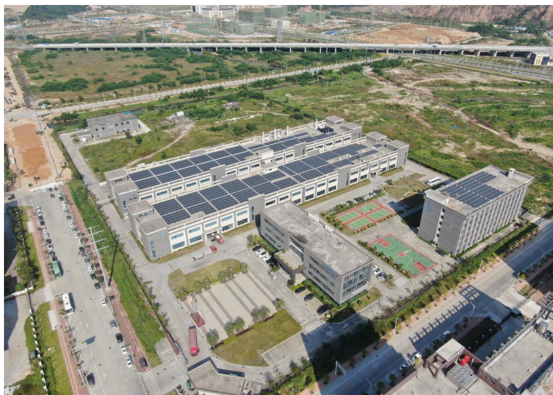
场地内已建建筑、道路
