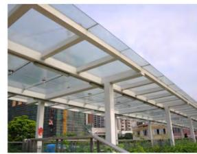
图7 钢结构骨架+钢化夹胶玻璃顶棚
