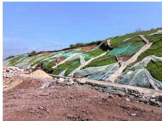
图 1 一、二级坡面左侧滑塌
